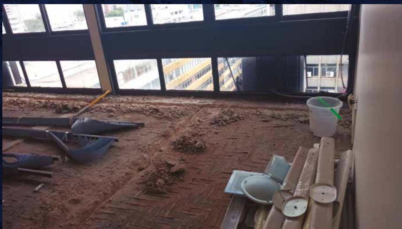
■ Obras preparam o 10 ° andar do Edifício Ceará para abrigar a ANAPE
